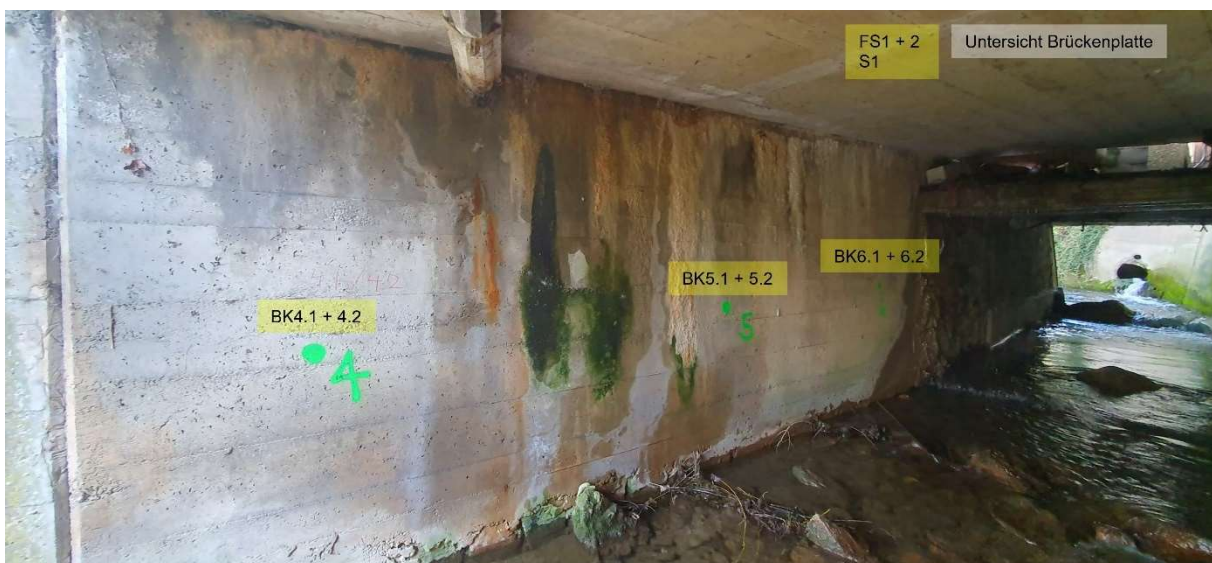
Abbildung 7: Probenahmestellen Widerlager (Quelle: Bericht "Zustandserfassung Betonbau")
