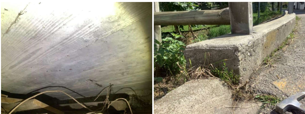
Abbildung 4: Brückenplatte und Bordüre Brücke Gemeinde (Quelle: Bericht Hauptinspektion)
