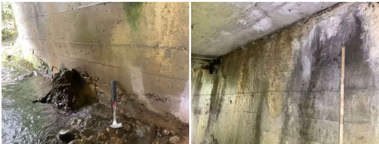
Abbildung 3: Widerlager Brücke Gemeinde (Quelle: Bericht Hauptinspektion)
